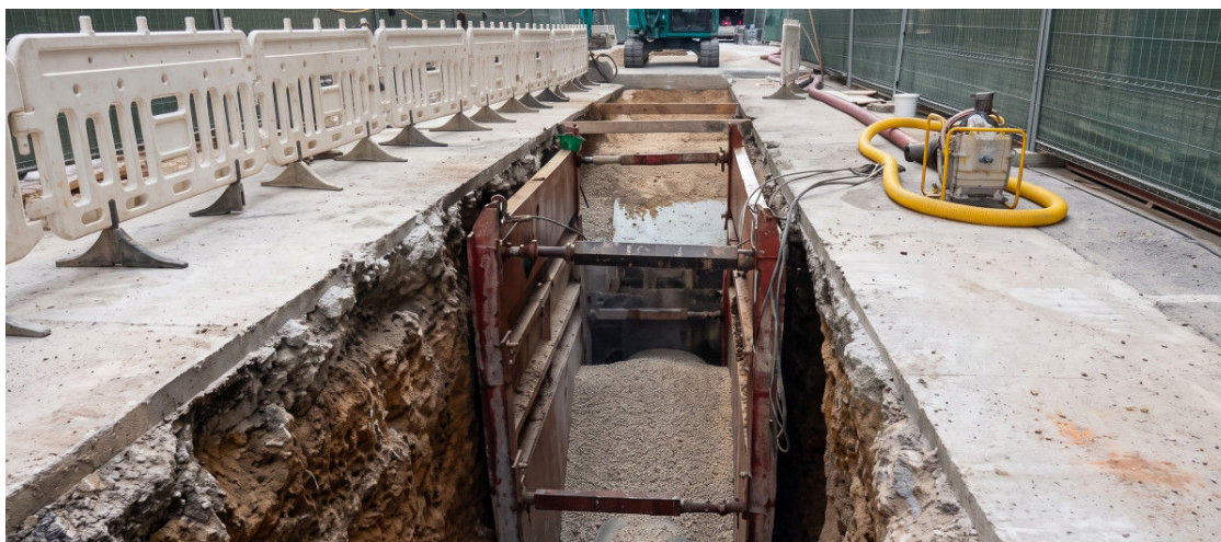
Imagen de una de las obras en ejecuciónEl Debate
